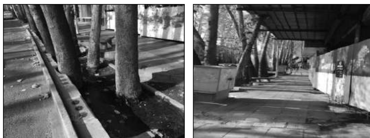
تصاویری از ساخت‌وسازهای غیراصولی در حاشیه خیابان ولی‌عصر (عج) و بتونه کردن بستر کشت درختان در تهران
