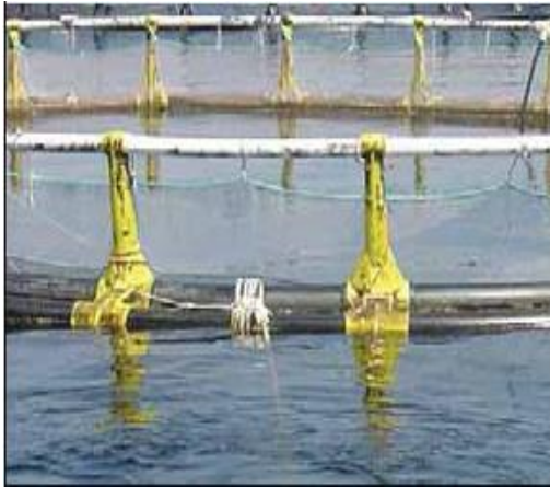
شکل ۵۰. خط زنجیر مهار محکم شده به لوله‌های یک حلقه قفس لوله‌ای دوگانه
