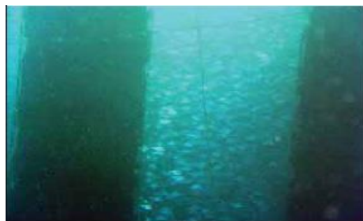
عکس ۸۵. پاکسازی زیر آبی دیواره توری یک قفس با شوینده آب-جت پرفشار. به نوارهای عمودی توجه کنید.
