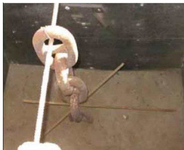
عکس ۴. قاب آهنی مورد استفاده برای ساخت بلوک بتنی در محل
