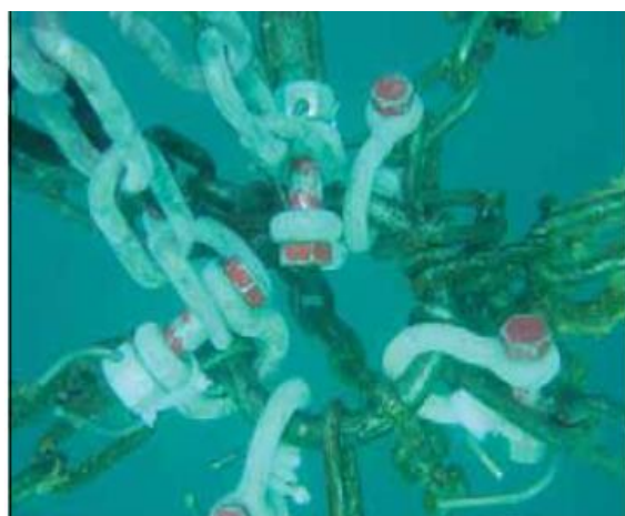
عکس ۱۶. حلقه فولادی مدور مورد استفاده بعنوان عامل اتصال در سیستم شبکه
