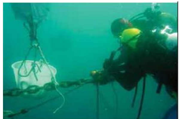
شکل ۴۳. جابجایی قلاب خط شبکه به صفحه کنکتور
