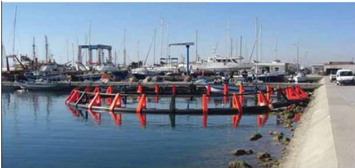
شکل ۴۷. طوقه قفس تکمیل شده؛ به براکت‌ها با رنگ‌های مختلف توجه کنید، براکت مشکی جایی که به زنجیرهای مهاربندی متصل است را نشان می‌دهد.
