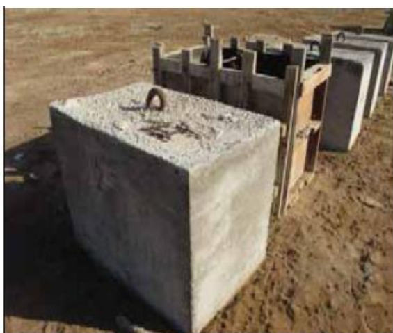
عکس ۵. قالب چوبی («فریم») برای ساخت بلوک های بتنی صنعتی
