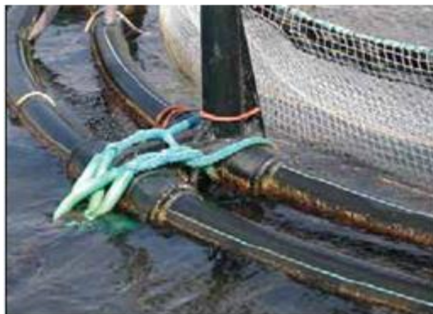
عکس ۵۲. یک روش دیگر ایمن سازی زنجیر مهار، اتصال حلقه طناب آبی به دو چشمی است (که با شیلنگ پلاستیکی پوشانده شده تا از سائیدگی طناب جلوگیری شود). حلقه روی براکت محکم شده و سپس زنجیر مهار روی چشمی‌های فلزی محکم شده است. گره ترجیحی برای ایمن سازی خط زنجیر مهار در شکل ۳۳ نشان داده شده است.
