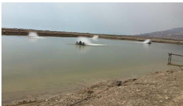
شکل ۴: فرسایش دیواره استخر و کاهش عمق آن
