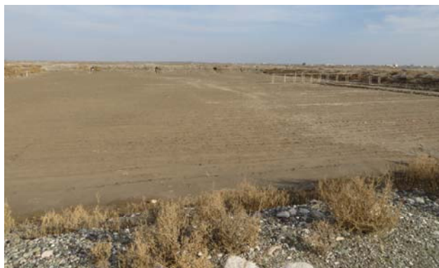
شکل ۵: تخلیه آب و خشک کردن استخر
