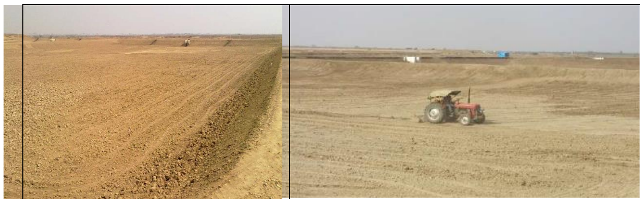
شکل ۹: شخم زنی و یکدست نمودن خاک کف استخر
