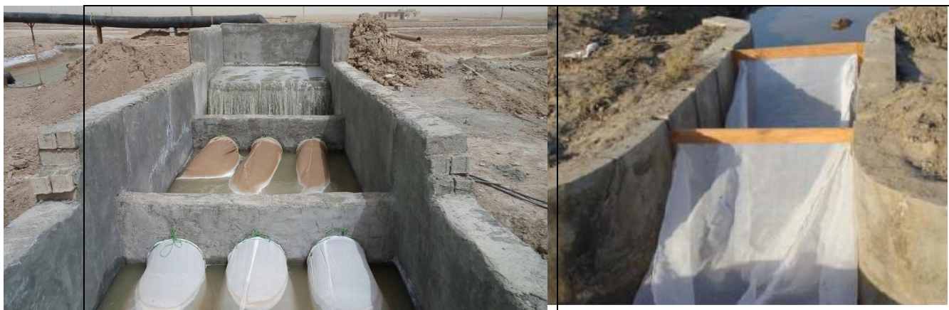
شکل ۱۰: استفاده از فیلتر در ورودی آب به مزرعه
