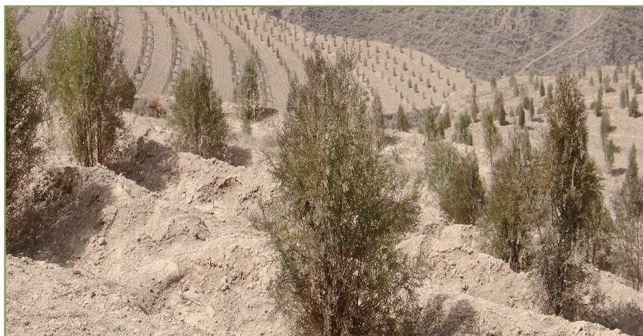
شکل ۴۲: استحصال آب باران از طریق جمع‌آوری رواناب در پشته‌های تراز
