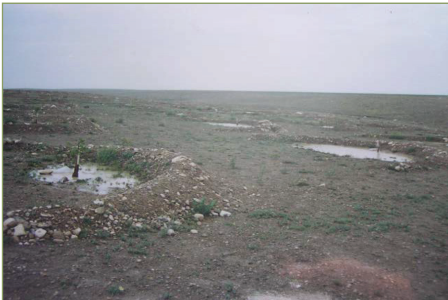
شکل ۳۳: استحصال آب باران از طریق جمع آوری رواناب در سامانه‌های دایره‌ای شکل
