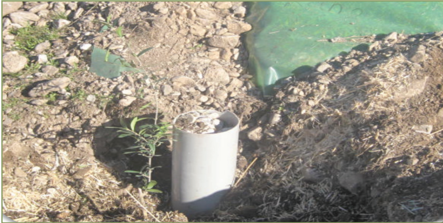
شکل ۳۰: نهال غرس شده در کنار لوله پر شده از سنگریزه
