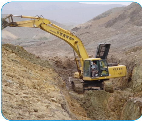
شکل ۶- گودبرداری جهت احداث مخزن سد
