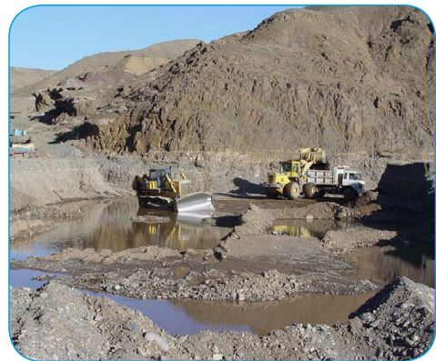
شکل ۶- گودبرداری جهت احداث مخزن سد
