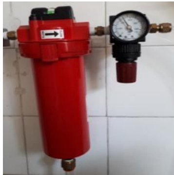
شکل 4- فیلتر جذب رطوبت
