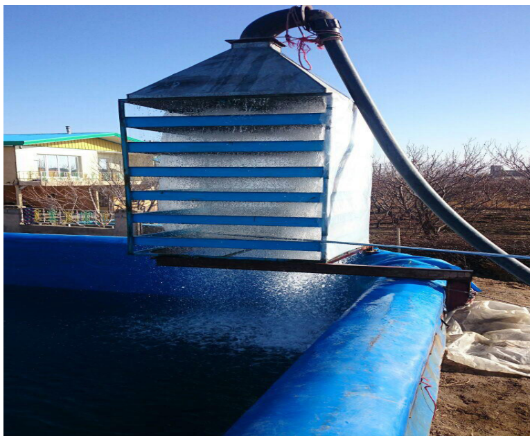
شکل ۱۹- سیستم هوادهی آب ورودی فاقد اکسیژن مناسب (برج هواده)
