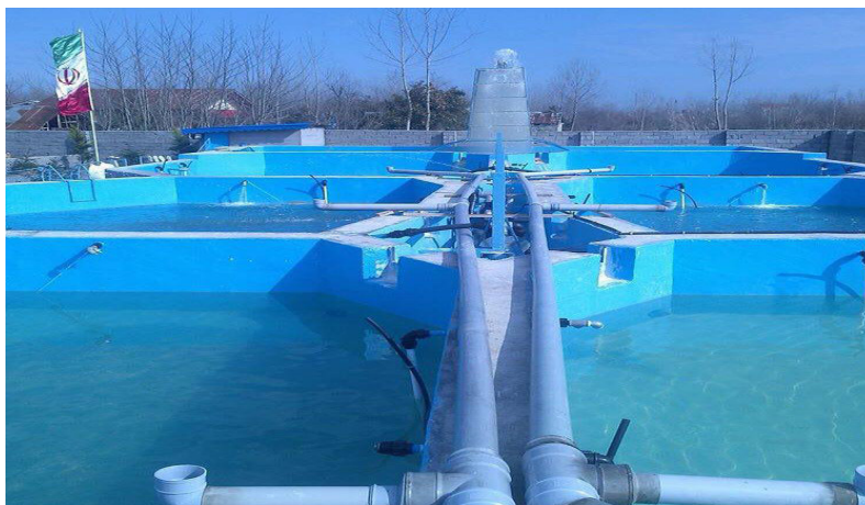
شکل ۲۴- تجهیز و آبیگری استخرهای پرورشی هشت ضلعی ماهیان خاویاری (مزرعه ندای خزر)
