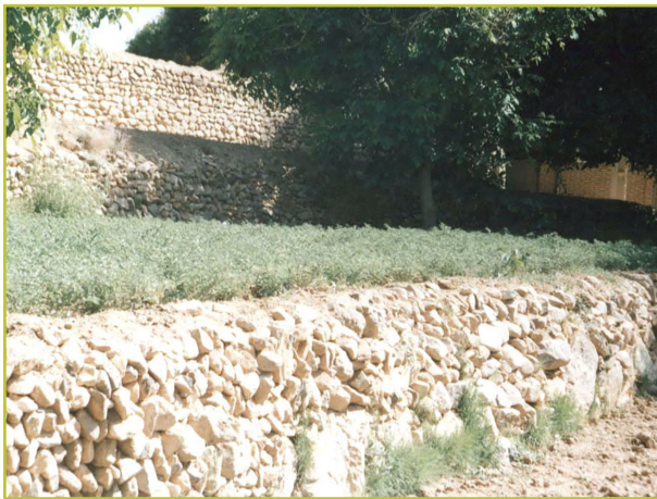
شکل ۳- سکوبندی با دیواره سنگی در اراضی شیب دار برای جلوگیری از فرسایش خاک و صرفه جویی در مصرف آب
