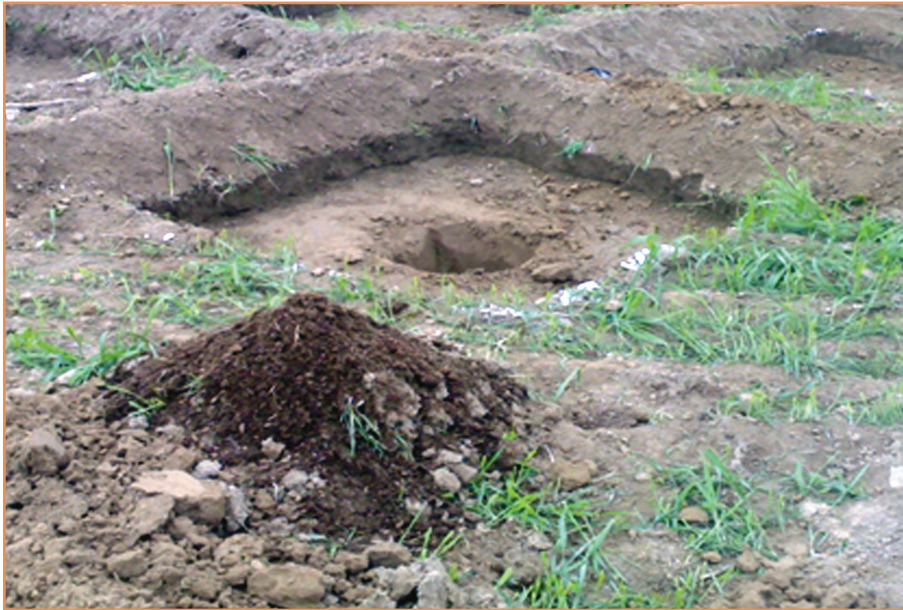
شکل ۳- نحوه ایجاد چاله‌های کاشت نهال در سامانه‌ها
