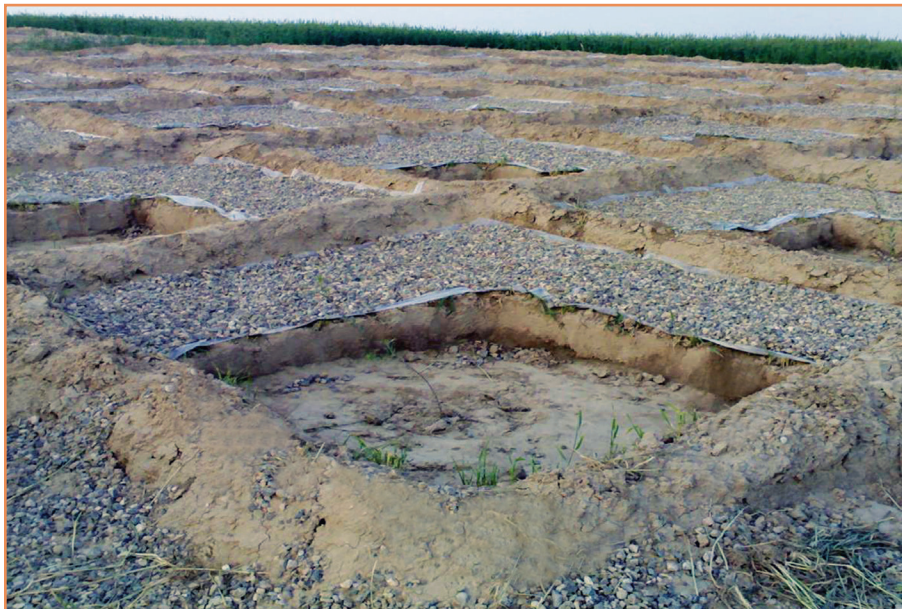
شکل ۱- ساخت سامانه‌های لوزی شکل روی زمین
