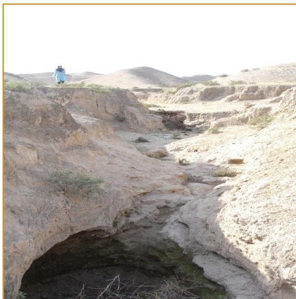
شکل ۴- ریزش سقف کانال زیرزمینی و پیدا شدن خندق در سطح زمین
