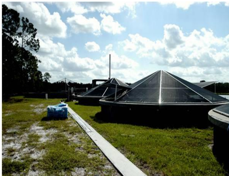
تصویر ۱۲: استفاده از سایه بان جداگانه بر روی هر حوضچه برای جلوگیری از تاثیر نور بر ماهیان
