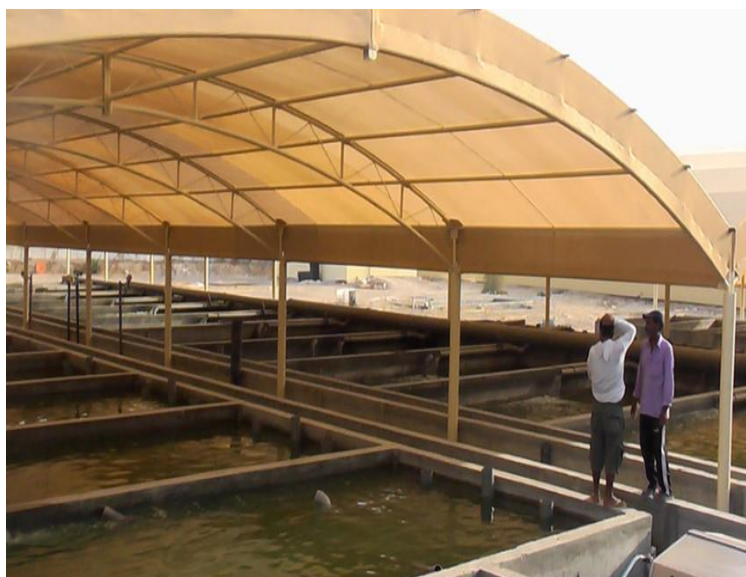
تصویر ۱۰: استفاده از سایه بان برای جلوگیری از تاثیر نور بر ماهیان
