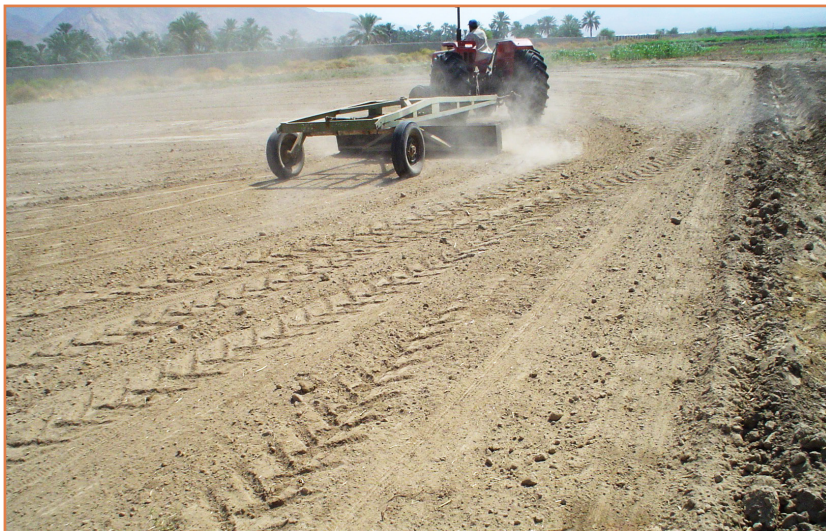
شکل ۲- عملیات تسطیح زمین
