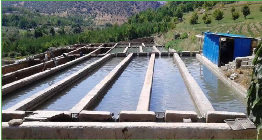
شکل ۱- تصویری از استخرهای پرورش ماهی قزل‌آلا با ساختار مستطیل شکل
