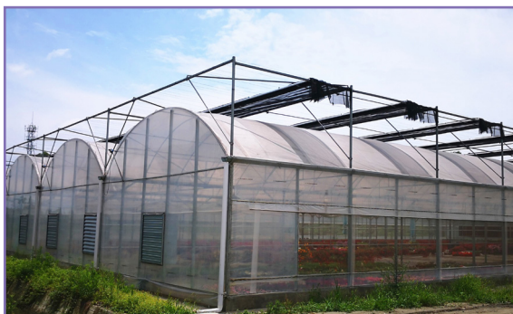
شکل ۶- نصب توری سایه‌انداز خودکار سطح بیرونی گلخانه
