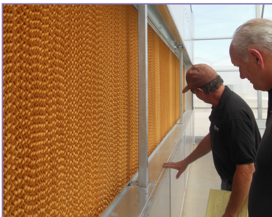
شکل ۴۰- نصب پد در دیواره طولی گلخانه
