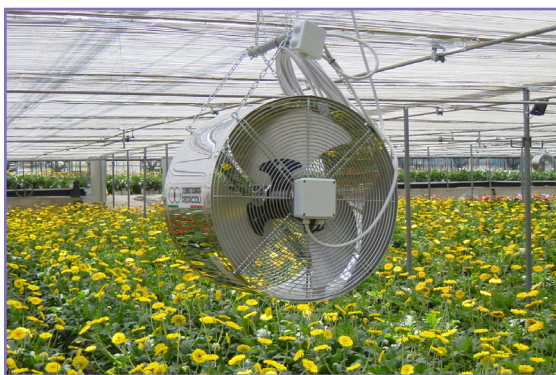
شکل ۲۳- فن سیرکوله برای گردش هوا در گلخانه
