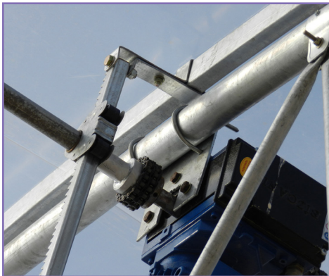
شکل ۱۹- سیستم برقی باز و بسته کردن دریچه سقفی
