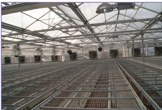
شکل ۴۶- نصب فن‌های تخلیه با فواصل منظم از یکدیگر و بالاتر از سطح کشت
