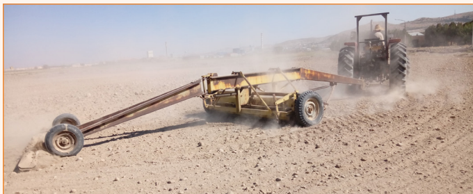
شکل ۹- دستگاه لولر در حال تسطیح زمین قبل از کاشت
