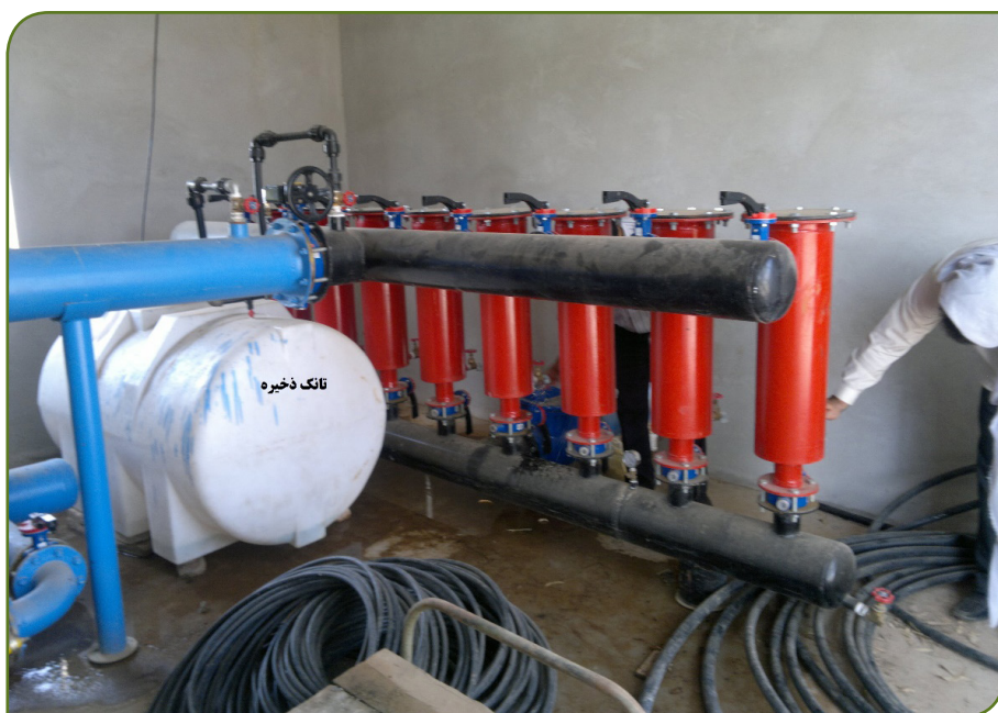
شکل ۲- تانک ذخیره کود و مواد شیمیایی در ایستگاه پمپاژ
