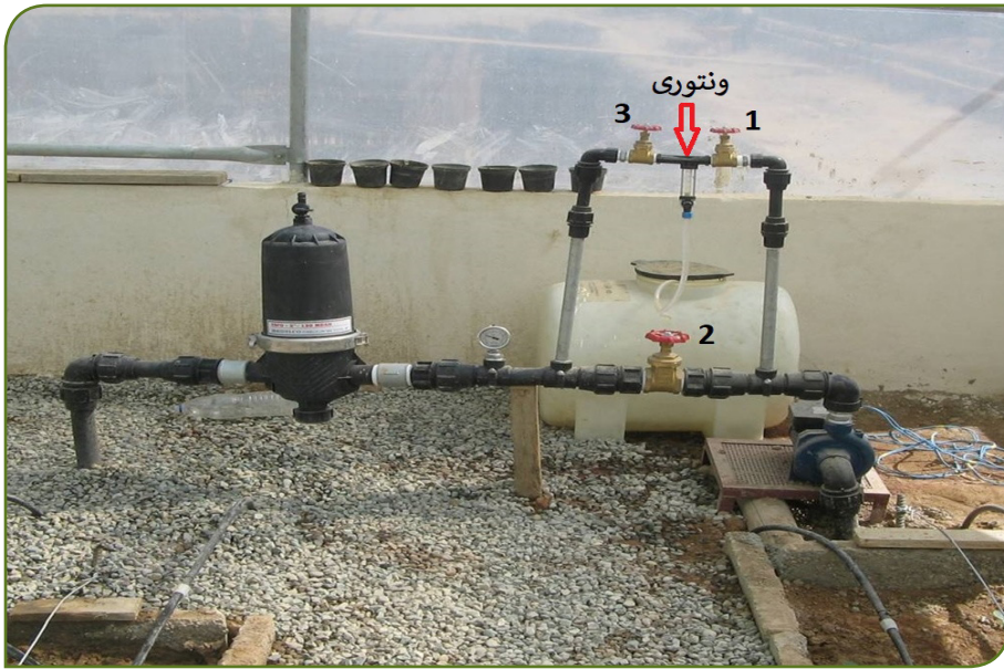
شکل ۶- نمونه‌ای از تزریق کود یا مواد شیمیایی به سیستم آبیاری با استفاده از ونتوری با گرفتن انشعاب از لوله اصلی
