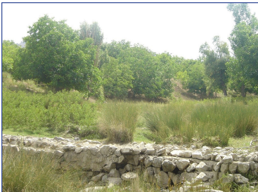
شکل ۵- نمایی از بند سنگ و سیمانی احداث‌شده در حوضه و کشت درختان مثمر و غیرمثمر توسط آبخیزنشینان در مخزن بند
