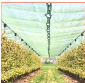
۶. پایان احداث سایبان
