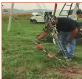
۳. نصب آنکر و اتصال سیم ها به آنکر
