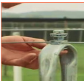
۲. نصب سرستون و کابل
