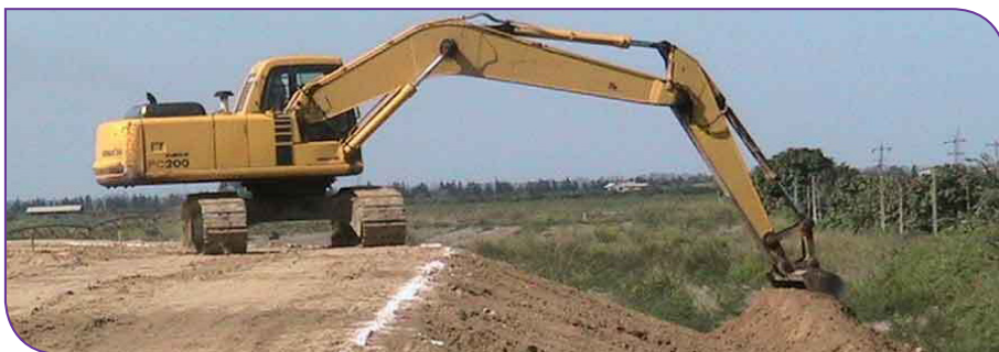
شکل ۸- دیواره‌سازی آب‌بندان و تعمیر و مرمت آن
