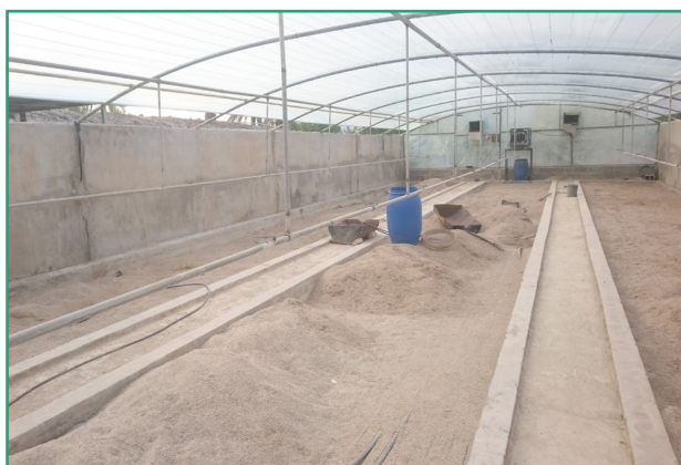
شکل ۵- سازه لوله گالوانیزه با پوشش پلاستیکی حاوی مواد ضد اشعه ماوراء بنفش (UV)
