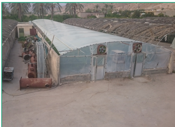
شکل ۴- سازه لوله گالوانیزه با پوشش پلاستیکی دارای مواد ضد اشعه ماوراء بنفش (UV)
