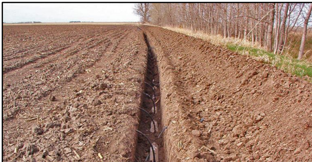
شکل ۱۲- لوله‌های زیر زمینی آبیاری قطره‌ای
