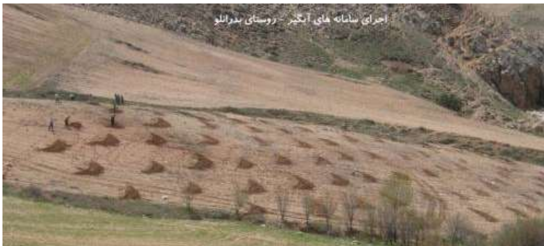
شکل ۵- اجرای سامانه های آبگیر با طرح لوزی
