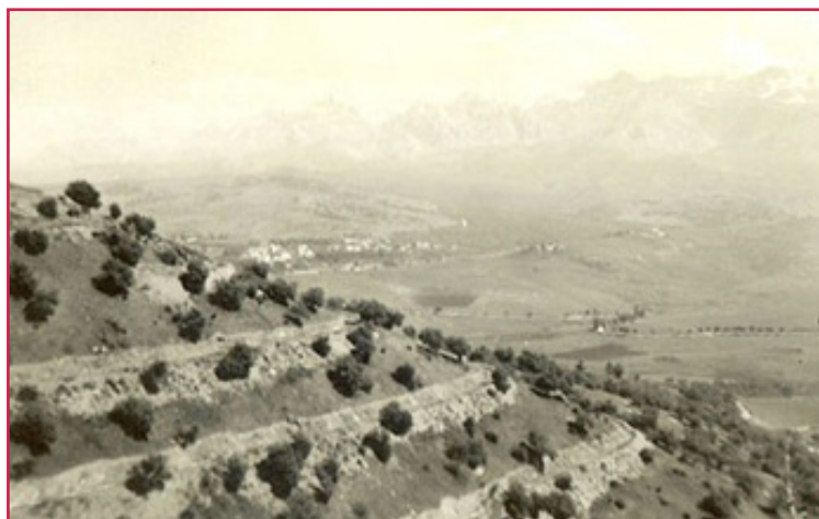
شکل ۱-۶ ب: تصویر چند ردیف بانکت بر روی دامنه شیب دار
