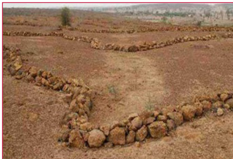
شکل ۱-۱۱- مهار سیلاب در روش سنگچین بر روی خطوط تراز
